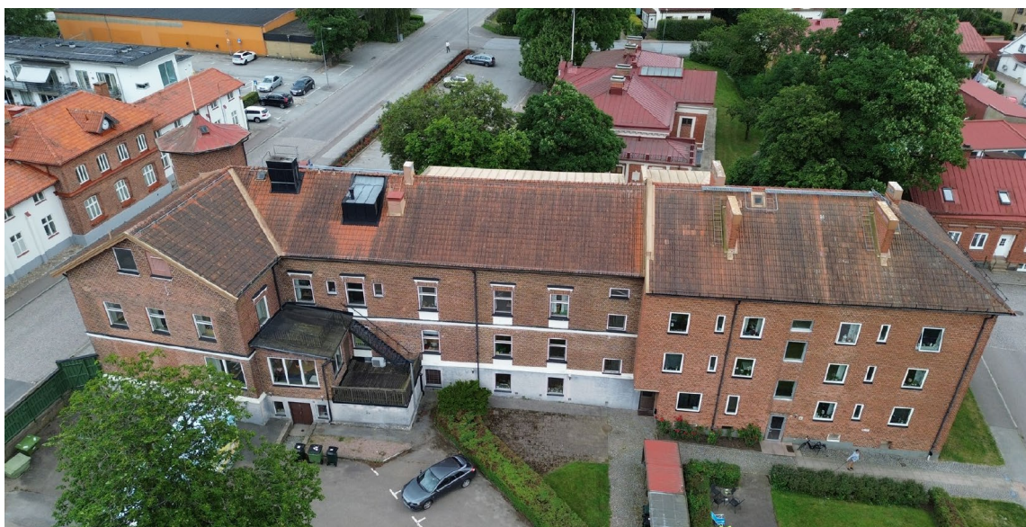
Flygvy från väster som visar de västra fasaderna, terrassutbyggnaden och takbeläggning.
