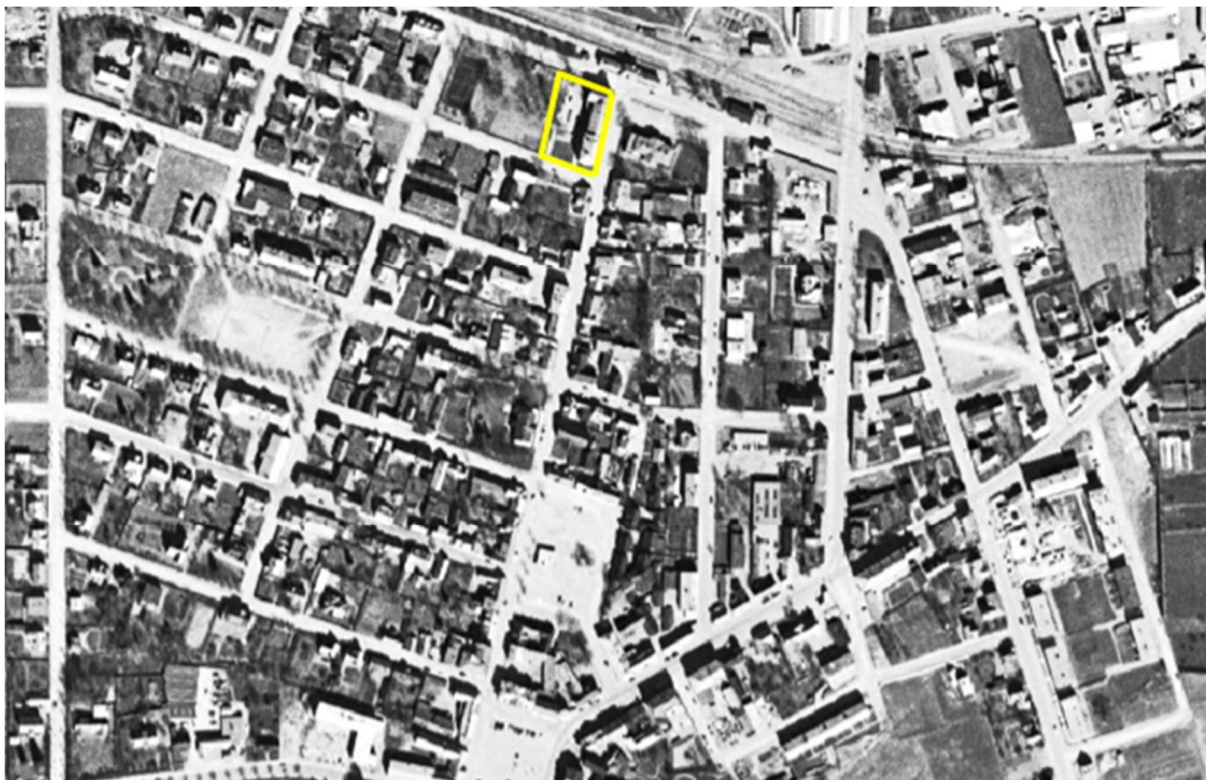
Figur 9.4. Gulalinjer markerar lokaliseringen av fastigheten på ett flygfoto från ca 1960 talet. Källa: Vattenatlas, hämtad 250701.
