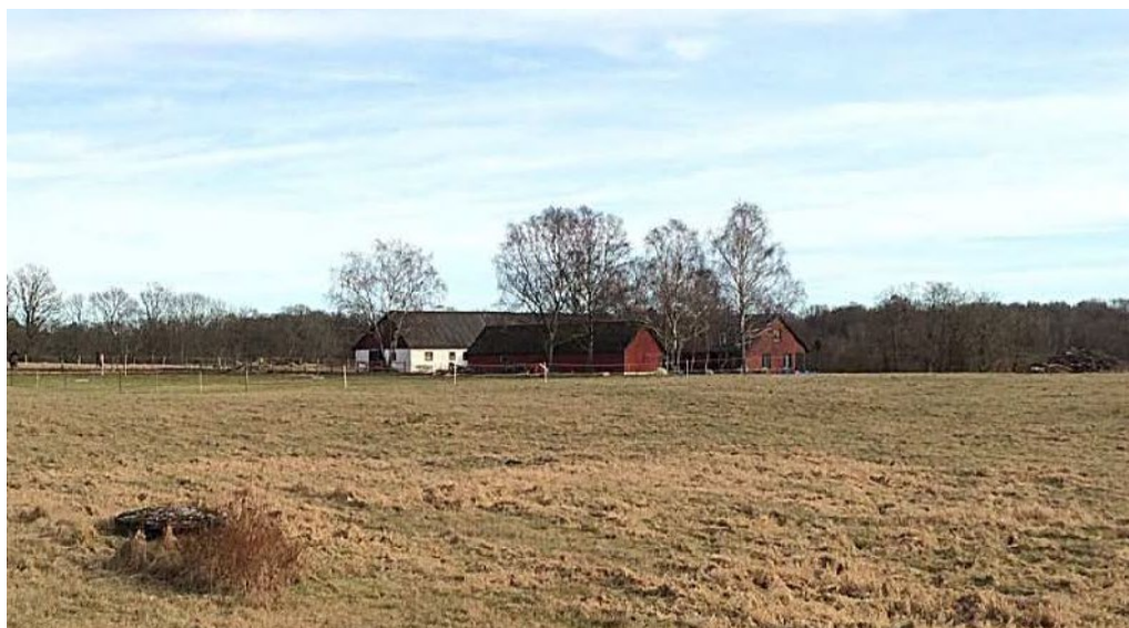
Vy från väst mot befintliga gårdsbyggnader
