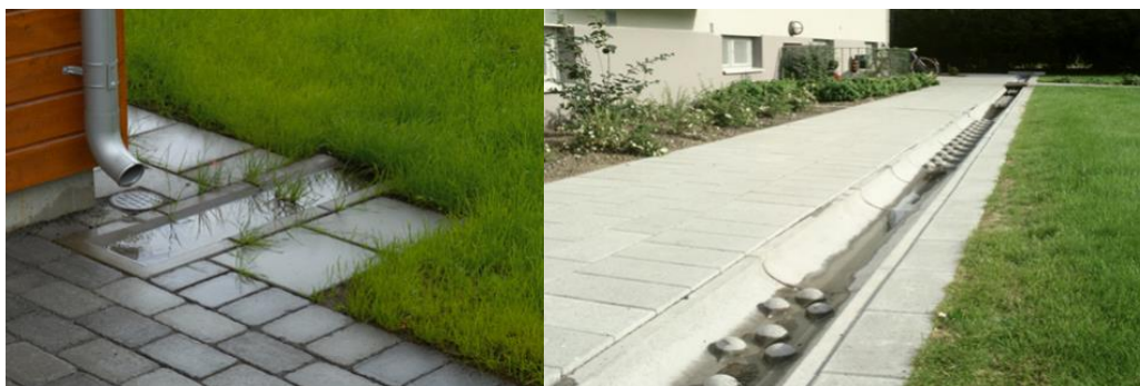
Figur 14. Vattenutkastare och dagvattenrännor, bilder från steriks.se.
