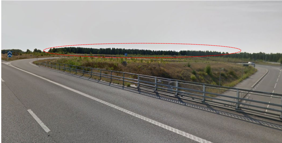
Vy från väg E22 mot planområdet. Röd streckad linje markerar granskog i fonden som försvinner i och med exploateringen (Bild från Google maps). Mellan vägen finns ung vegetation som är under tillväxt.
