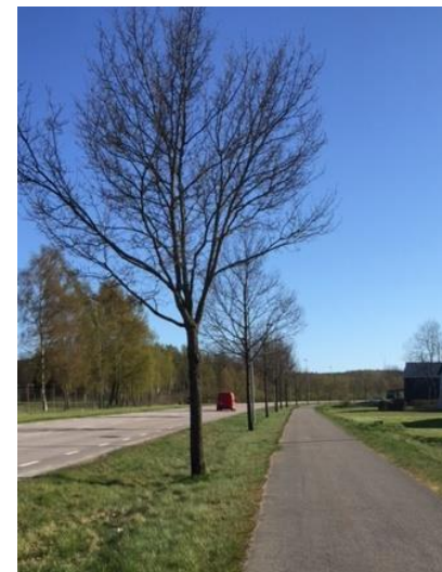
Figur 3. Dike med trädplantering mellan väg och cykelväg
