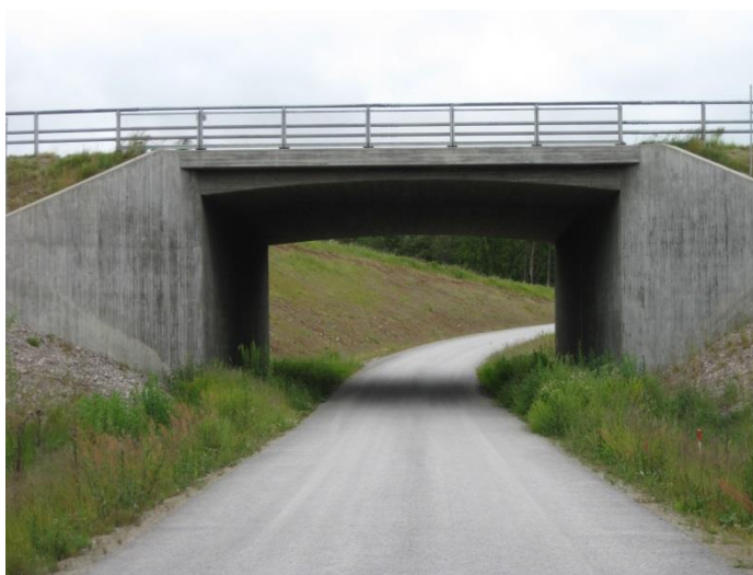
Figur 4 Viadukt under E22:an
