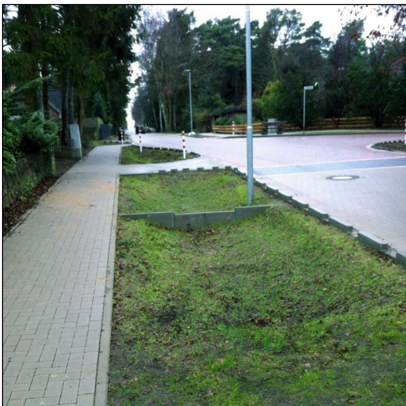
Figur 11. Exempel på svackdike (Foto: WRS).
