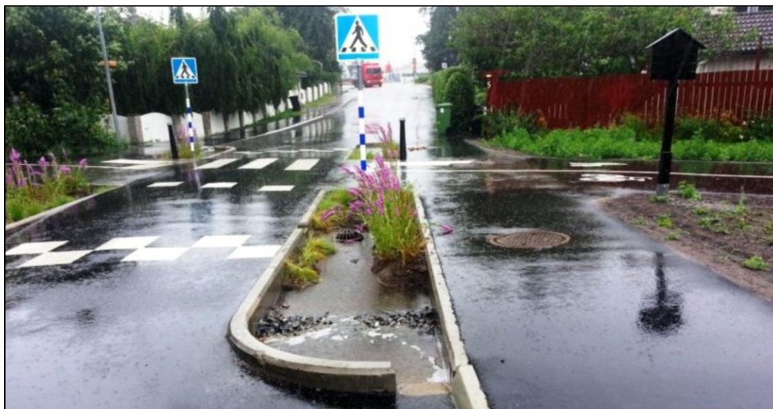
Figur 13. Exempel på regnbädd (Bildkälla: VA-guiden).
