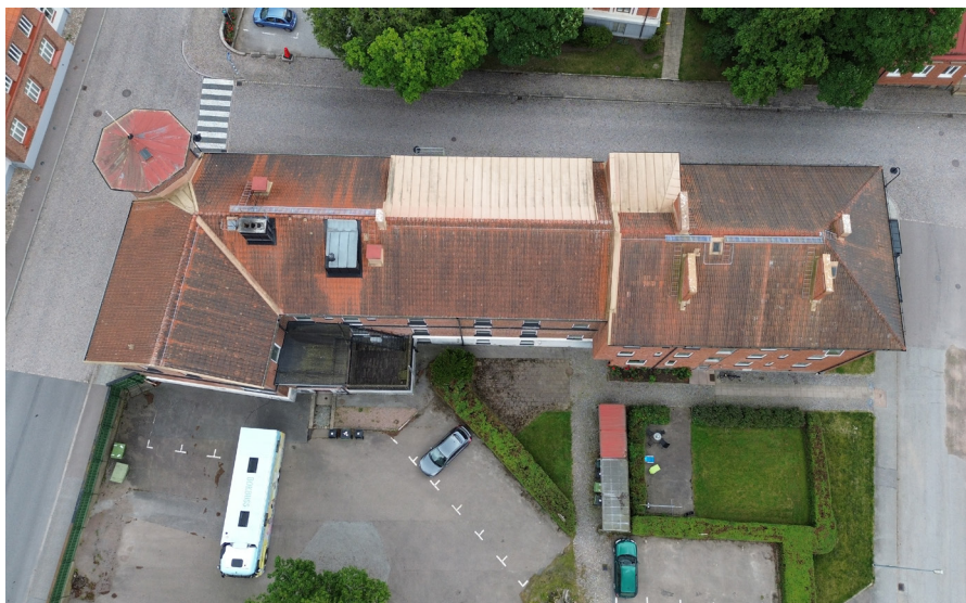
Flygvy över byggnadens tak.
