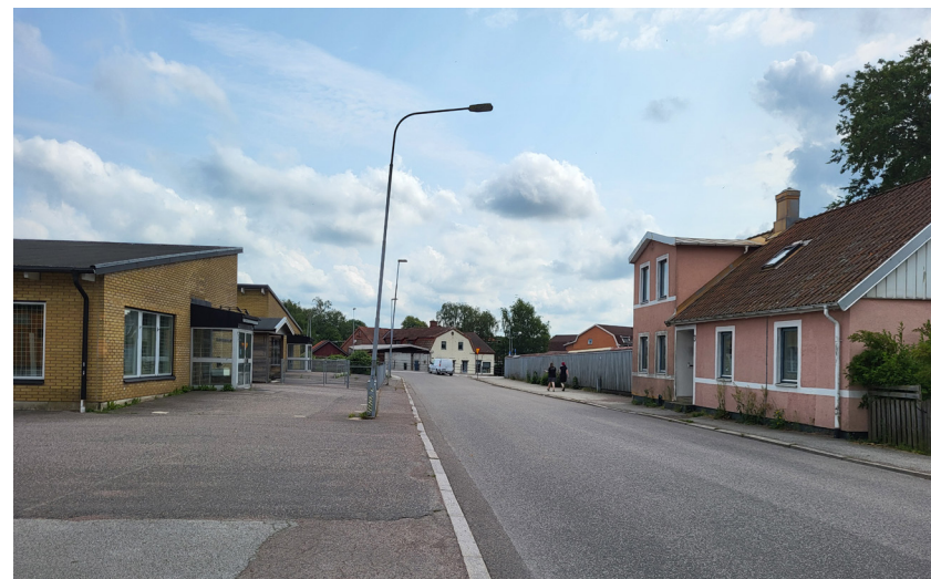
Östra delen av Vallgatan. På södra sidan av gatan (höger) finns en ensam äldre villa, följt av en stor staketomgärdad tomt. På norra sidan (vänster) finns ett fåtal glest placerade låga tegelbyggnader inrymmande verkstad, service- och handelsfunktioner (idag bl.a. ett litet livs). I fonden det gamla mejeriet.
