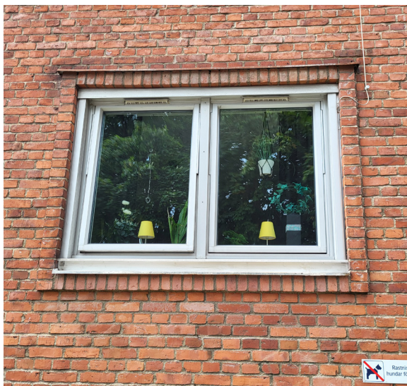
Fönstren i bottenvåningen har svagt utskjutande omfattningar av tegel.
