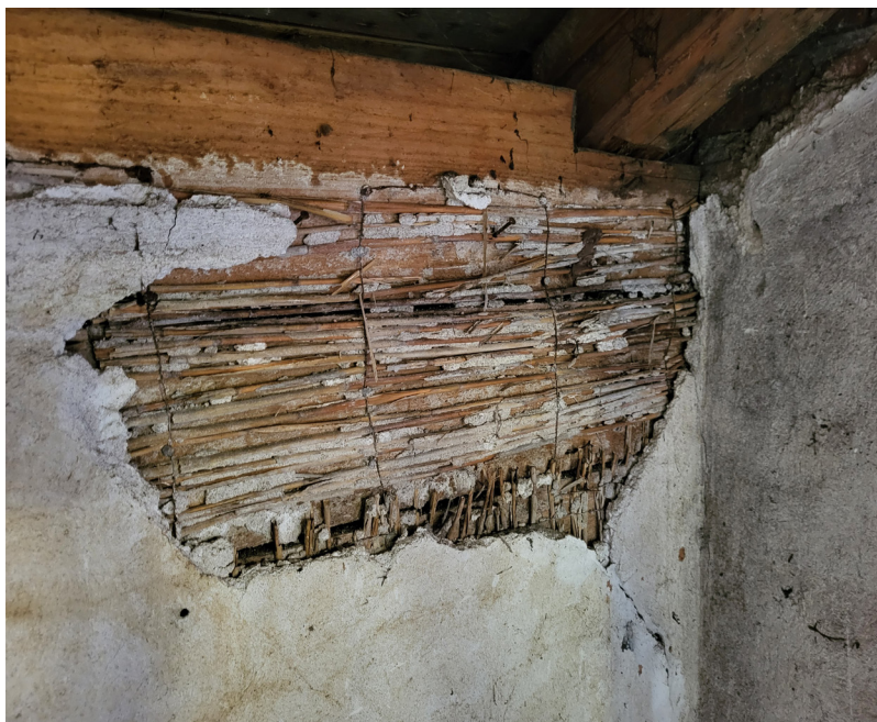
Bevarat äldre ytskikt på vind. Puts på vassmatta.
