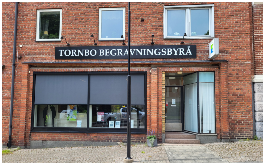
Skyltfönster och entré till lokal i bottenvåningen. Öppningarna merkeras av tegelomfattningar.
