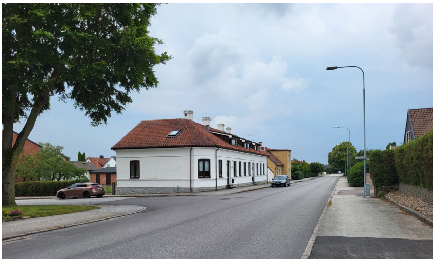
Det vita gathuset vid korsningen Vallgatan-Bollhusgatan är ett av få exempel på småskalig 1800-talsbebyggelse i detta område. Denna bebyggelse typ är vad som har dominerat längs samhället huvudgator, Nygatan och Storgatan.
