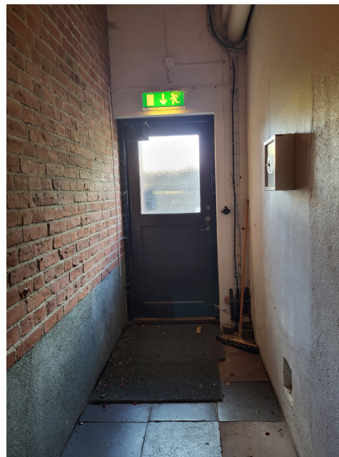
Entré mellan ursprunglig byggnad och tillbyggnad. Dörr med trådarmerat glas. Kalkstensgolv.
