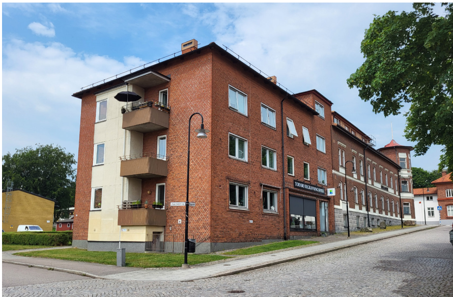
Vy från sydöst. Tillbyggnaden närmast i bild. I gaveln mot söder finns tre balkonger med fronter av brun, fint sinukorrugerad plåt, och ett burspråk inklätt i ljusa skivor.
