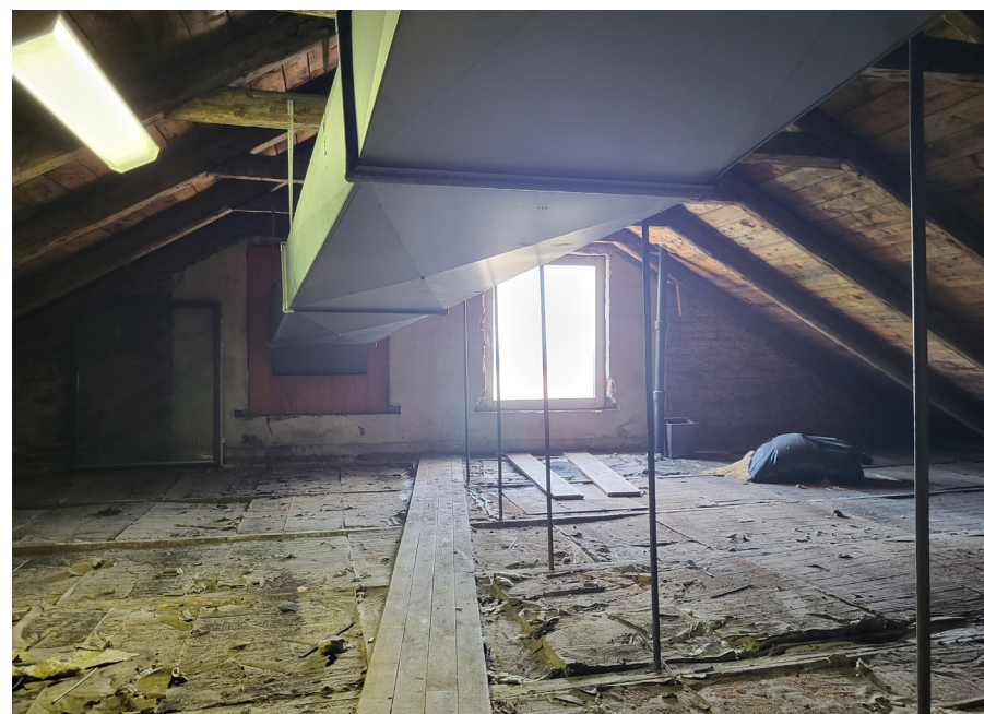
Vind och takstolar, gavel mot väst. Kanalisation till igensatt fönster.
