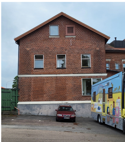
Gavel mot väst. I murverket finns pår efter tidigare öppningar. Det syns även spår efter den tidigare verandan mot trädgården.
