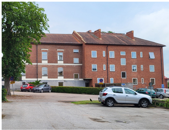
Vy från väst. Det finns en förskjutning mellan volymerna på tillbyggnaden och den ursprungliga byggnaden.
