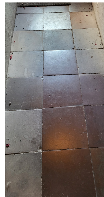
Entré mellan ursprunglig byggnad och tillbyggnad. Dörr med trådarmerat glas. Kalkstensgolv.
