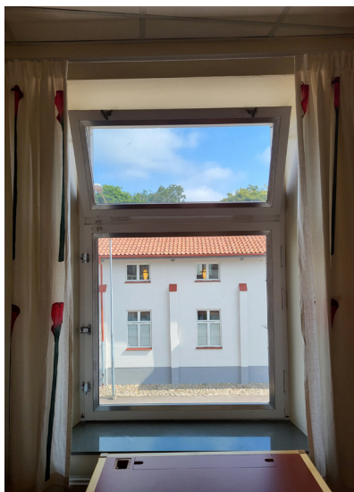
Fönster från insidan.
