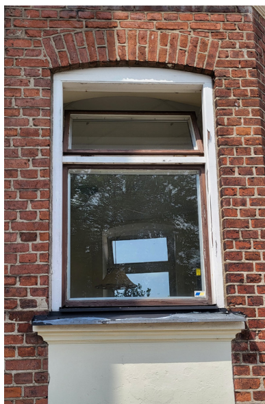
Fönsterna är ospröjsade tvåluftsfönster som härrör från 1940-talet.
