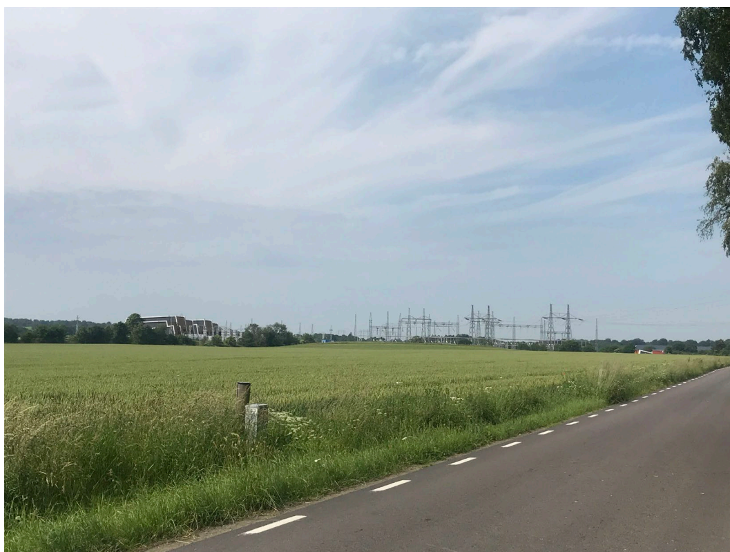
Figur 4. Fotot visar planområdet från väg 1121 med den befintliga stamnätsstationen "Hurva station" i bakgrunden. Den nya omriktarstationen föreslås hamna i anslutning till befintlig station.
