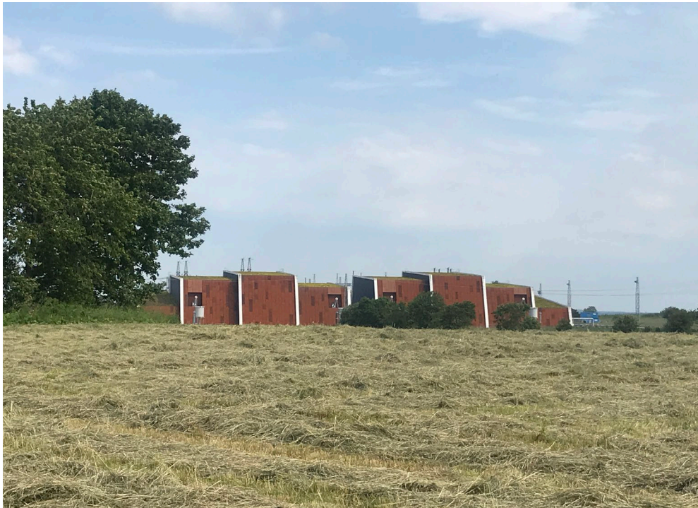
Figur 1: Foto över stamnätsstationen i Lyby, även kallad Hurva station. Den nya omriktaren för Hansa PowerBridge ska samlokaliseras med befintlig station.
