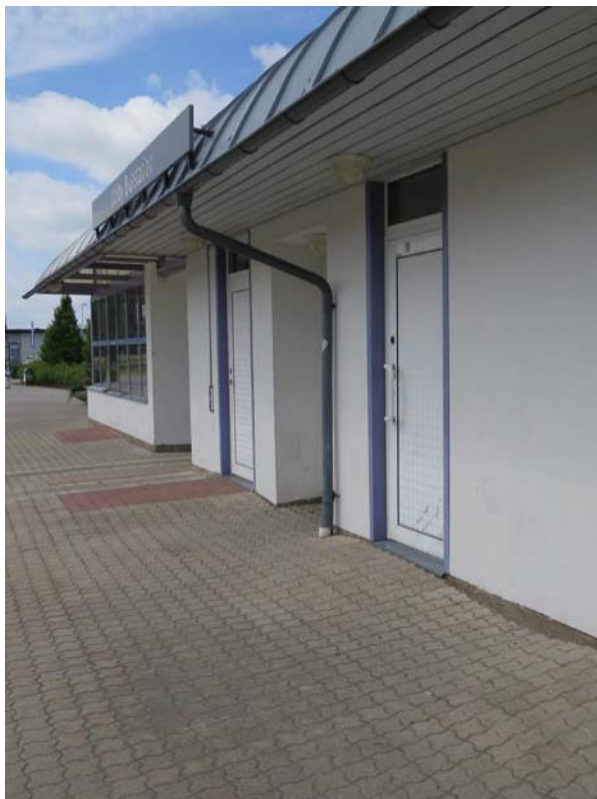
Markbeläggning intill byggnaden
