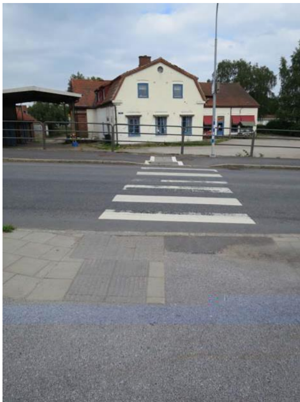
Övergångsställe med taktila och visuella markeringar
