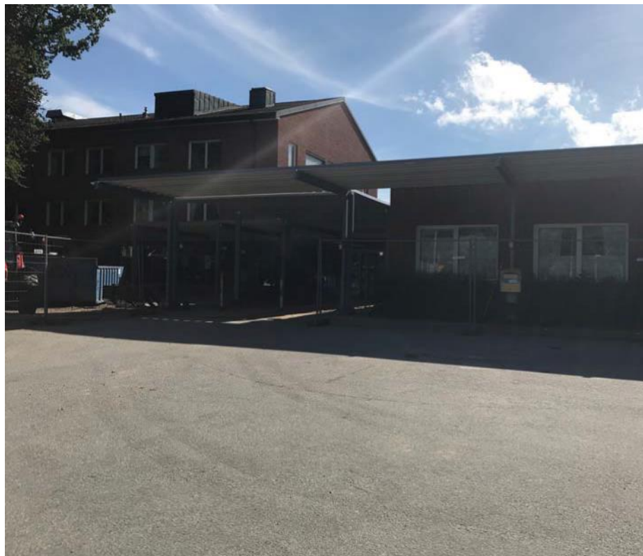
Entrén till vårdcentralen kan vara svår att upptäcka (Ombyggnad pågår)
