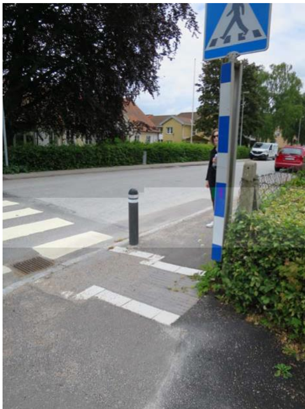
Övergångsställe med taktila och visuella markeringar
