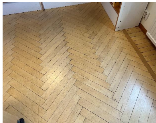
Figur 7. Äldre parkettgolv från 1940-talet som har funnits i f d kappfabrik. Inga synliga missfärgningar noterats.
