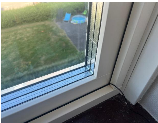
Figur 16. Nyare isolerglas (2000-tal) finns i lägenheterna i delen från 1946.
