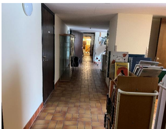
Figur 10. Nästa hela källaren har klinkergolv som bedöms var från ombyggnationen från 1978.
