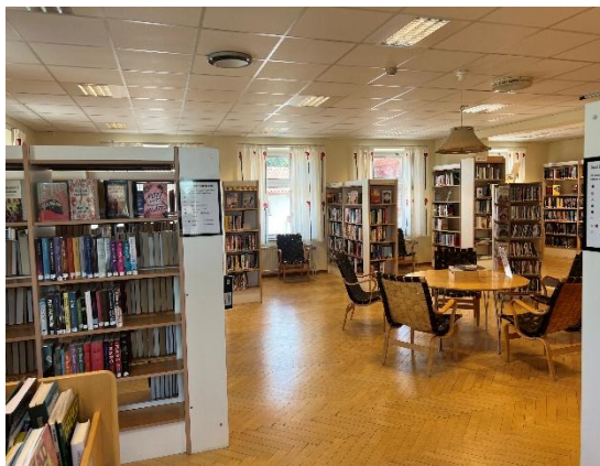
Figur 8. Äldre parkettgolv från 1940-talet som har funnits i f d kappfabrik. Inga synliga missfärgningar noterats.
