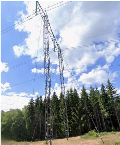
Figur 2. Befintlig kraftledningsstolpe norr om tilltänkt etablering (bild hämtad från Google street view).
