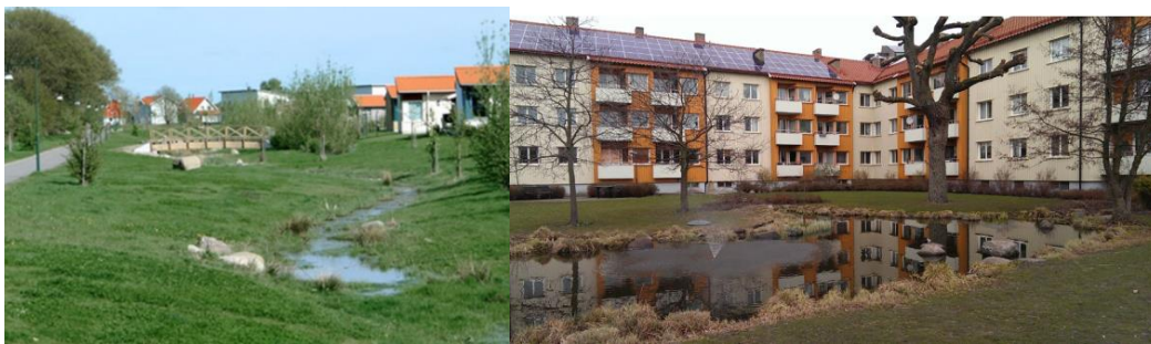
Figur 6.5 Principskisser på torra/våta fördröjningsdammar
