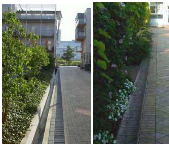
Figur 5.3 Exempel på dagvattenrännor för avledning av parkering platser eller takvatten från kvartermark.
