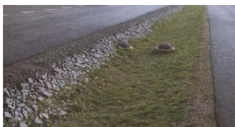
Figur 5.10 Exempel på utformning av Svackdike med bräddavlopp
